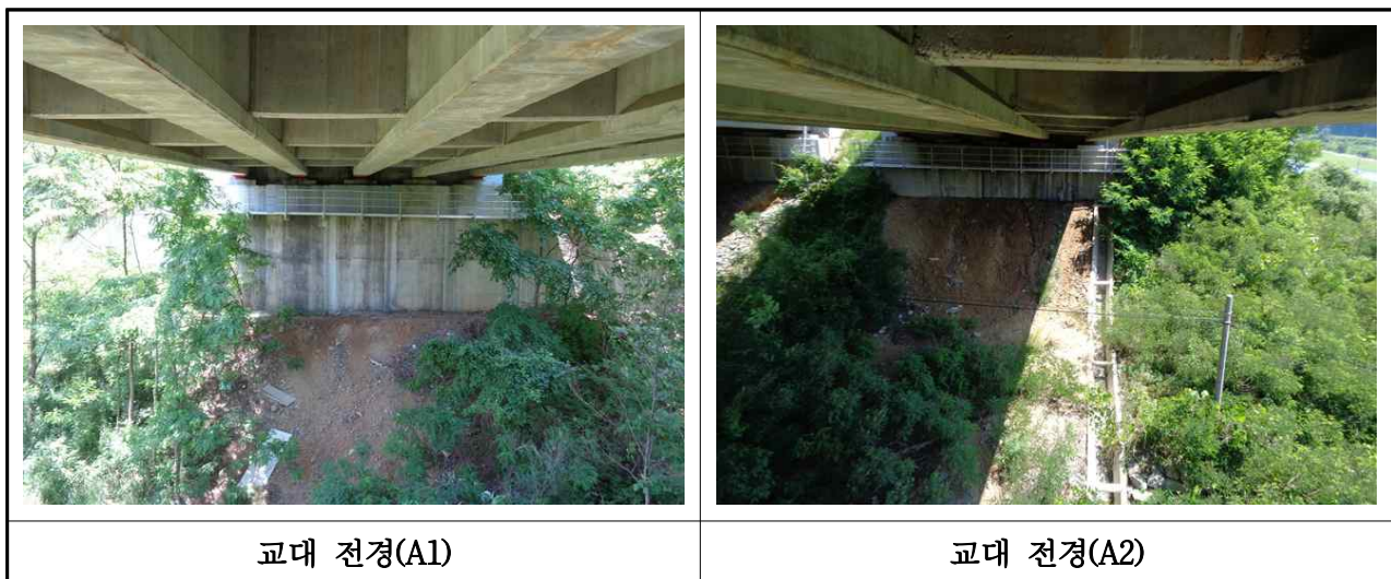
【사진 3.10】 교대 전경
