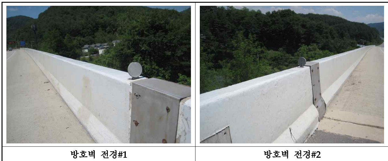
【사진 3.25】 방호벽 및 중앙분리대 전경
