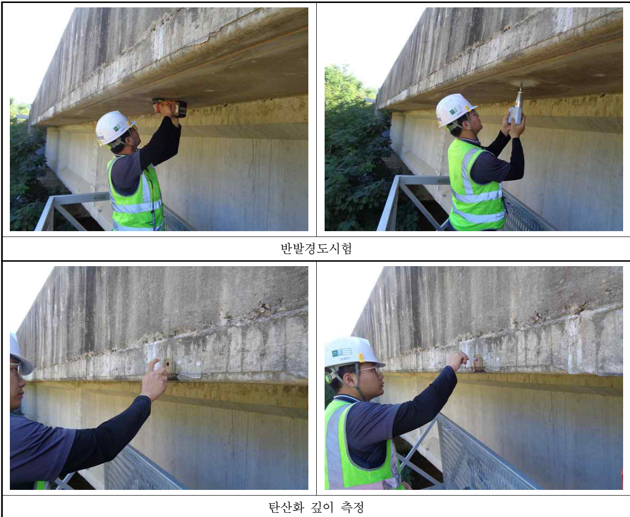
【사진 3.27】 콘크리트 내구성조사 현황
