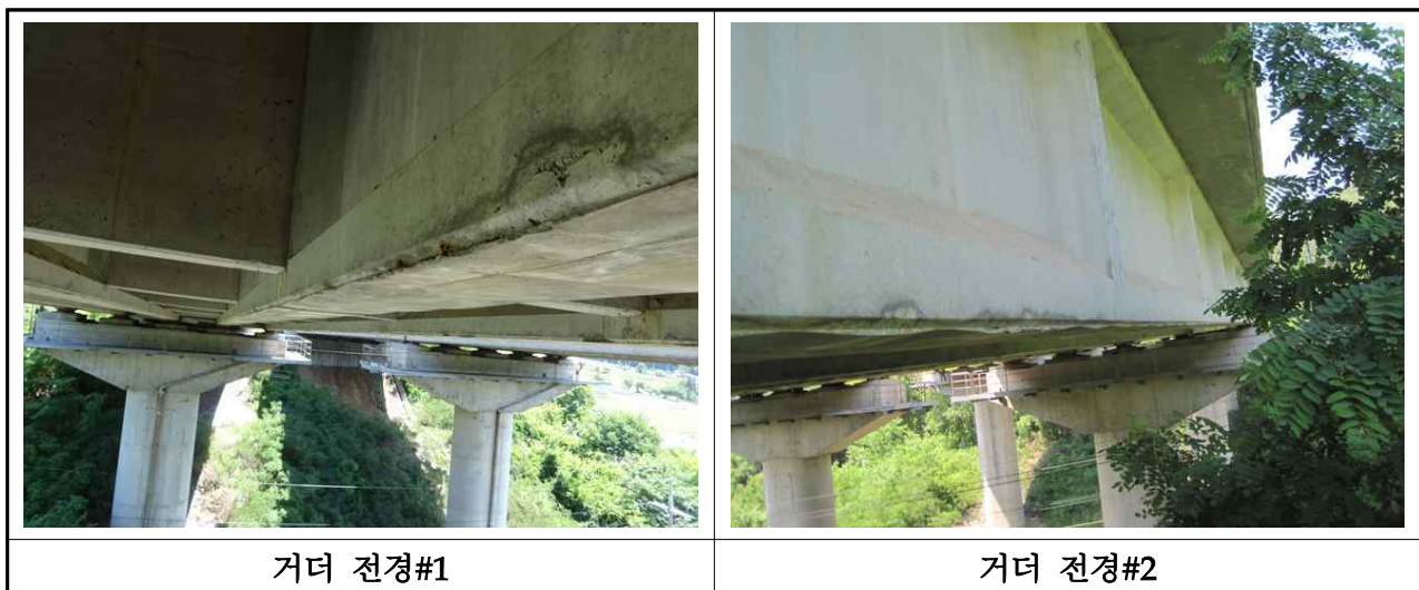
【사진 3.4】 거더 전경
