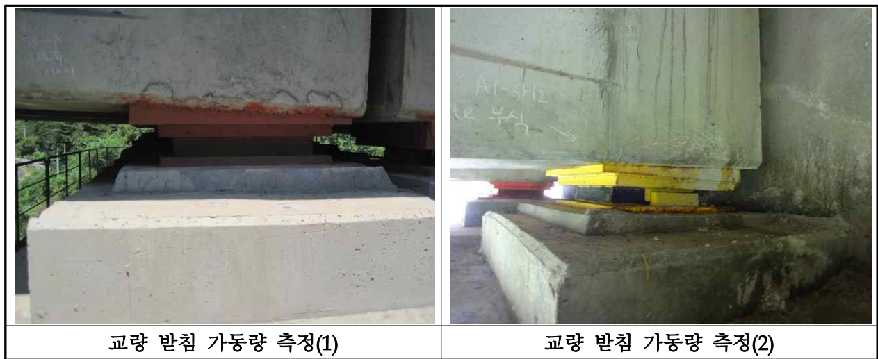
【사진 3.17】 교량받침 이동량 측정
