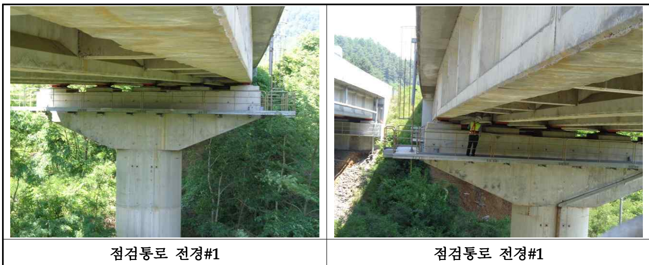
【사진 3.50】 교량 점검시설 전경
