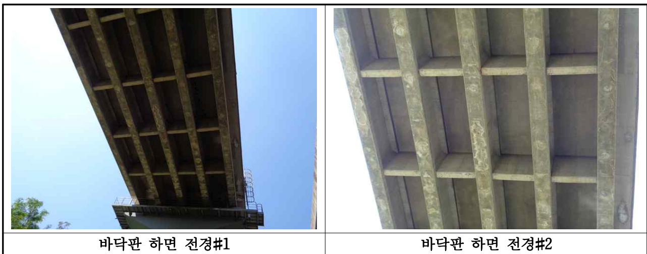
【사진 3.2】 바닥판 하면 전경
