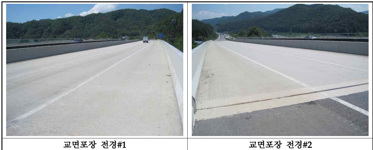
【사진 3.21】 교면포장 전경
