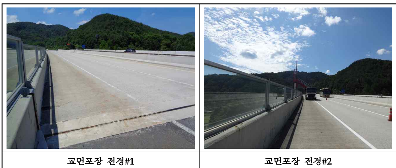
【사진 3.21】 교면포장 전경
