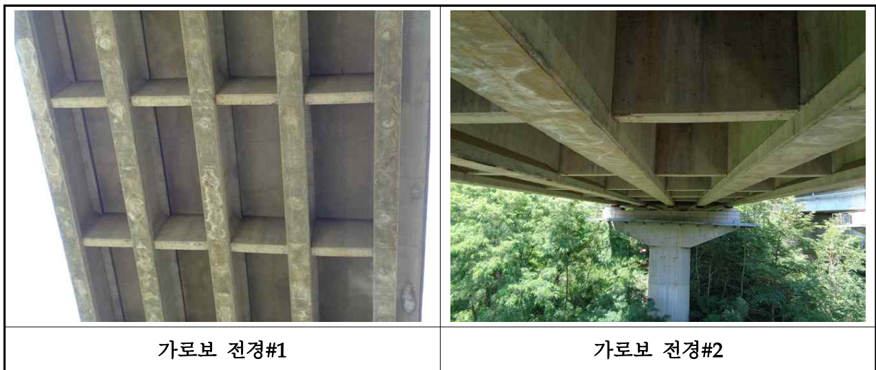
【사진 3.7】 가로보 전경
