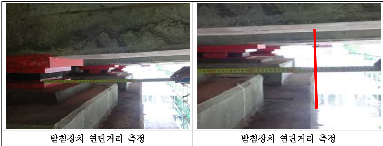
【사진 3.16】교량받침장치 연단거리측정
