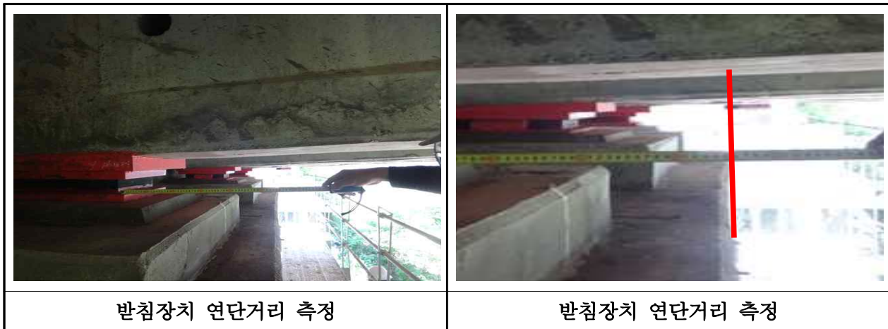
【사진 3.16】교량받침장치 연단거리측정
