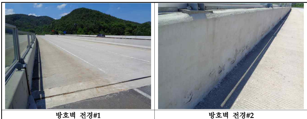
【사진 3.25】 방호벽 및 중앙분리대 전경
