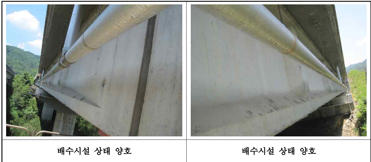
【사진 3.24】 배수시설 손상현황
