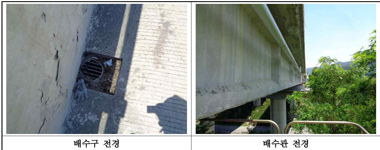
【사진 3.23】 배수시설 전경
