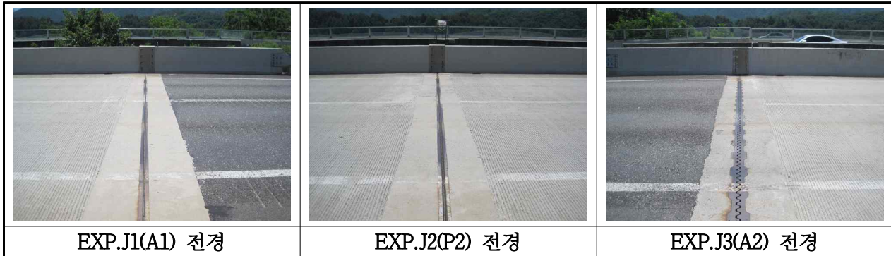
【사진 3.18】 신축이음장치 전경
