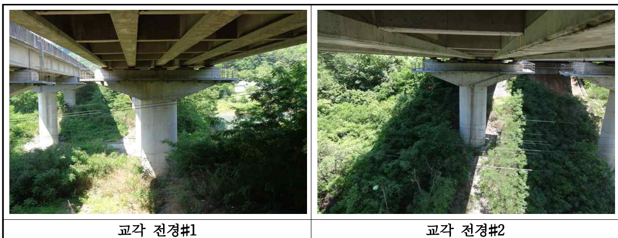
【사진 3.12】 교각 전경
