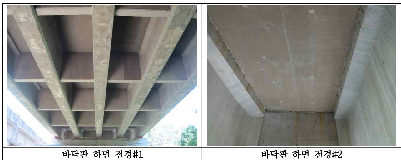
【사진 3.2】 바닥판 하면 전경
