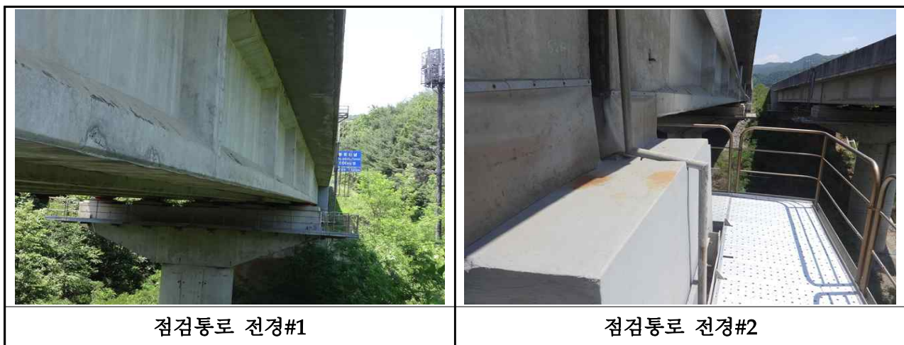
【사진 3.27】 교량 점검시설 전경
