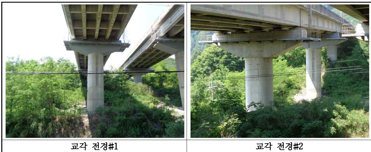
【사진 3.12】 교각 전경
