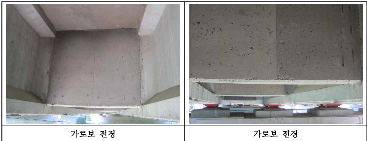
【사진 3.7】 가로보 전경
