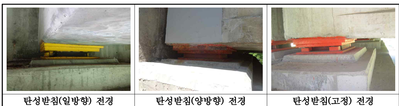
【사진 3.14】 교량받침 전경
